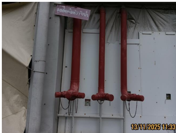
หัวรับน้ำดับเพลิงติดตั้งด้านข้างอาคาร
