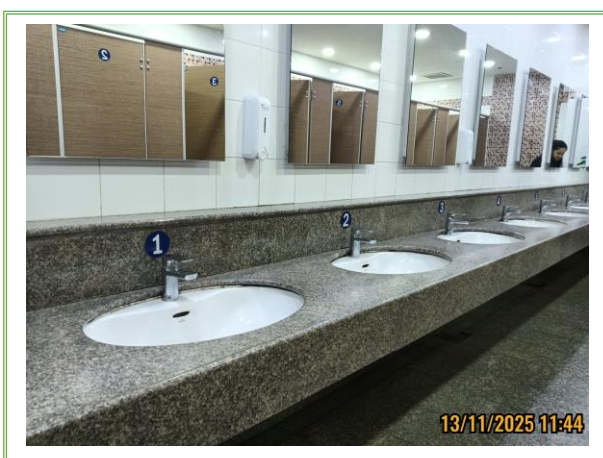
รูปที่ 3-38 ก๊อกน้ำชนิดกดแทนก๊อกน้ำแบบหมุน
