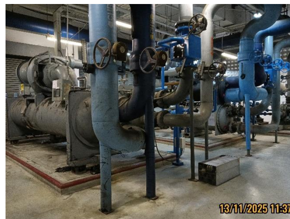
รูปที่ 2-5 ระบบทำความเย็น (Chiller)
